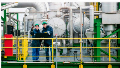
Das Chemiewerk Oxea stellt in Oberhausen auf G5-Service. Dieses integrierte Pump-, Steuerungsteil- und Überwachungssystem in seine informelle und Altagssysteme.
